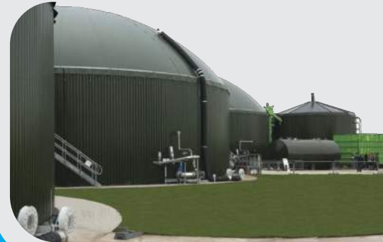
Biogás Digestión Anaeróbica
