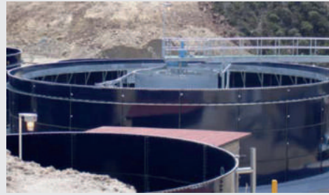
Tratamiento de Aguas Residuales Municipales
